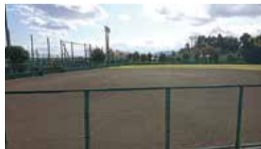
新旭球場の防護マットの設置
