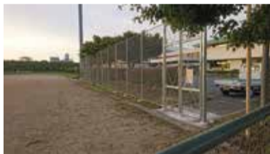
マキノグラウンドのフェンス設置
