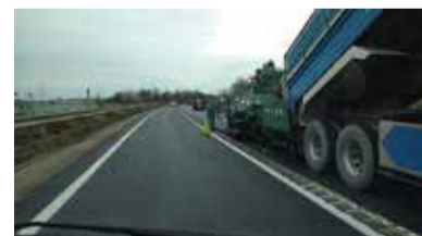
国道161号道路修復整備
