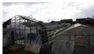
平成29年10月23日 台風21号に伴うパイプハウス被害 現場
